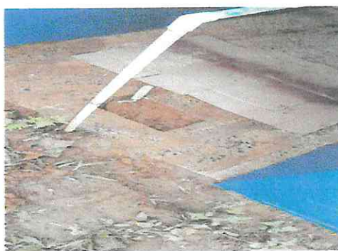
Reconstrucción de caja de drenaje para agua de pila y lavamanos
