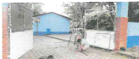
Mantenimiento de y colocación de lámina en portón
