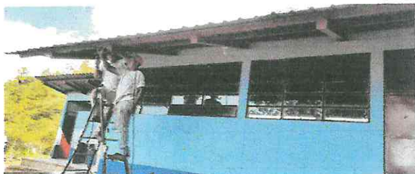
Colocación de canales y bajadas para agua pluvial
