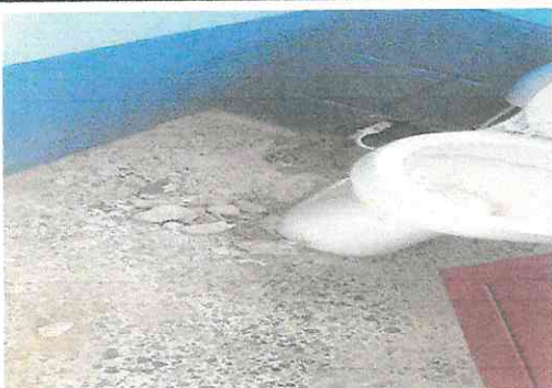
Mantenimiento de sanitarios
