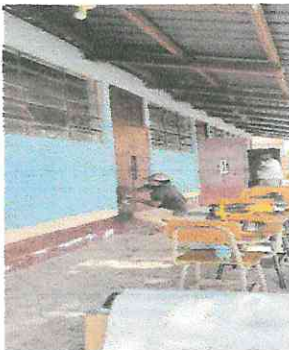
mantenimiento de puertas
